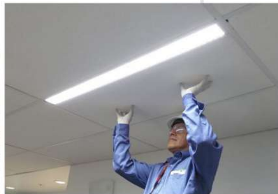
Instalación de Luminarias
